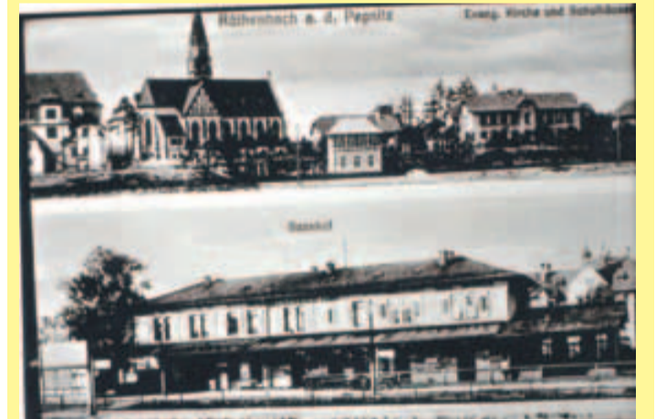
Die Röthenbacher Schulhäuser, die Kirche, das Stellwerk und unten der Bahnhof.
